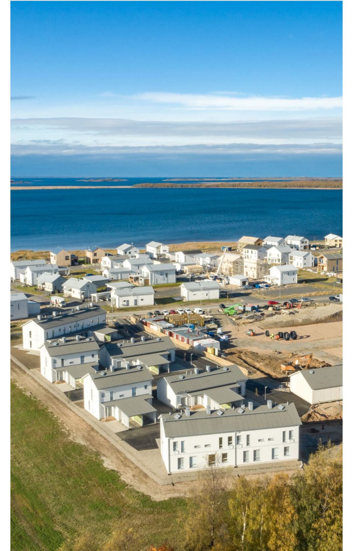
As Oy Oulun Pantturipiha 6-8 rakentuu aiemmin sahateollisuuden käytössä olleelle brownfield-alueelle Oulun Pateniemeen
